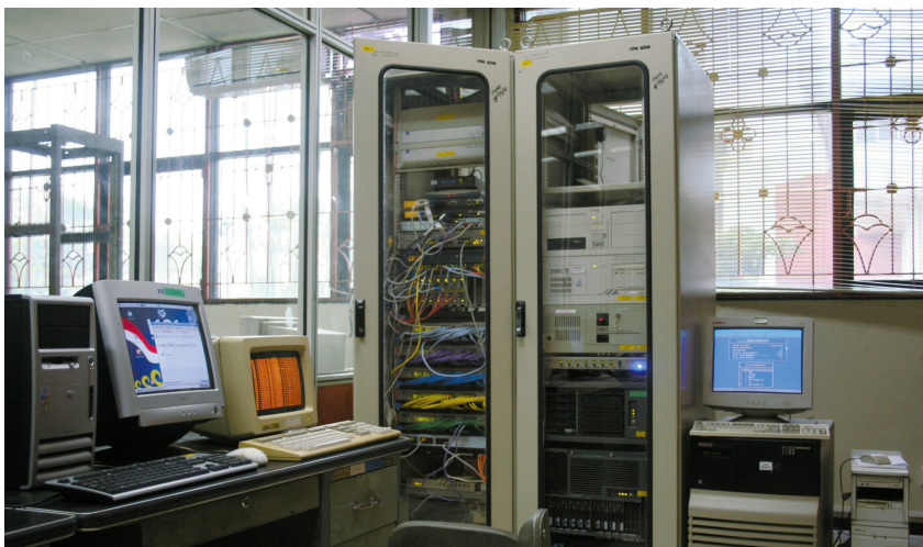
Linux-Linux di ruang server PPIN BATAN.
